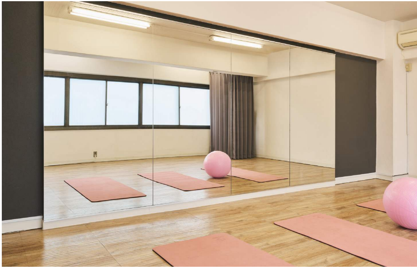
ヨガスタジオ クリアミラー6mm厚 W900×H1800 糸面取り小口磨き ×4枚
