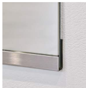
ステンレスチャンネル（上下に使用）
